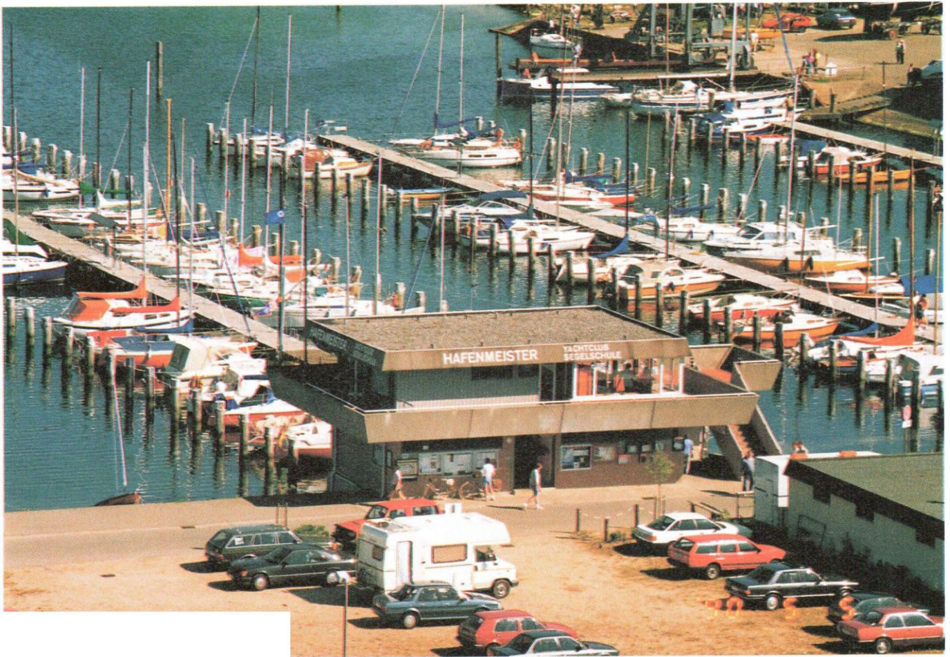
Hafenanlagen Marina Wendtorf
