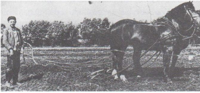
Hans-Peter Schneekloth beim Tiefpflügen.
