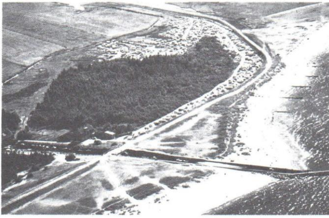
Blick auf die Wendtorfer Schleuse vor dem Bau des neuen Landesschutzdeiches.
