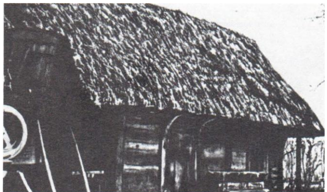
Bohllenspeicher auf dem Hof H. Wiese
