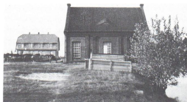
Das alte Schleusenwärterhaus mit dem Pumpenhaus.
