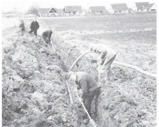
Jochen Wiese, Walter Müller und Karl Hilbert beim Verlegen der Drainagerohre.
