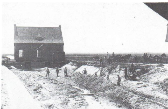
Bau des Schleusenkanals
