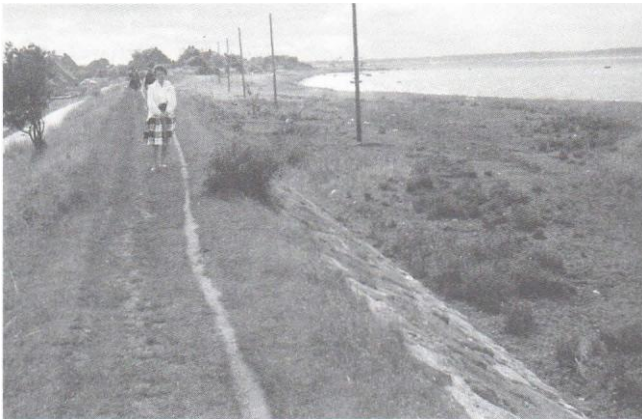
Wendtorfer Deich mit Felssteinböschung
