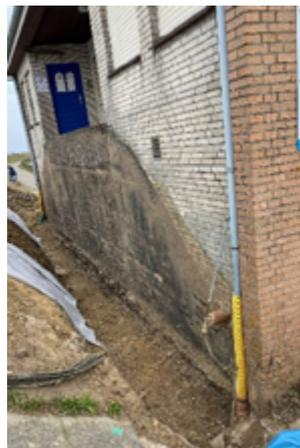
Zusätzlich wurde die Außenwand der Naturstation in diesem Jahr aufwändig saniert. Der komplette Deich wurde hier abgetragen und dann wurde die Außenwand mit einem Schutzanstrich versehen. Danach wurde wieder angefüllt und ein Unterbau für die spätere Pflasterung eingebaut. Auch diese Baustelle ruht bis ins Frühjahr 2022.
