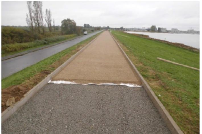
Der Unterbau mit Dränbeton in Vlies
